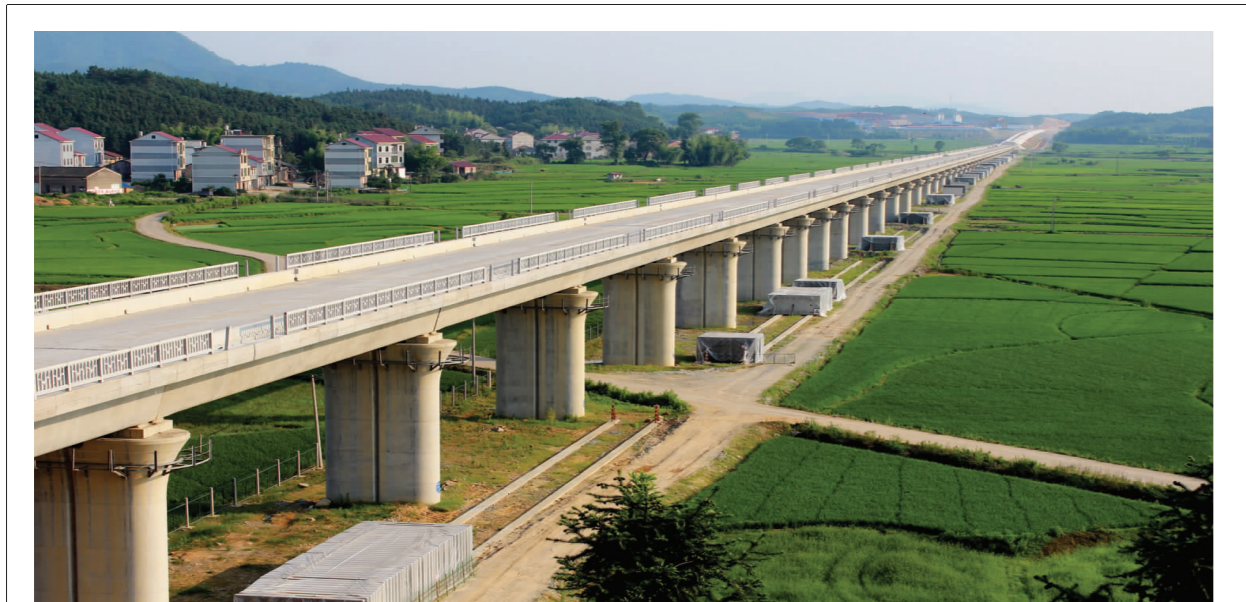
公司承建昌赣铁路项目全长34.8公里,其中桥梁24座总长18.6公里,于10月13日完成全部架梁任务。图为城田特大桥。(王杨阳/摄影报道)
