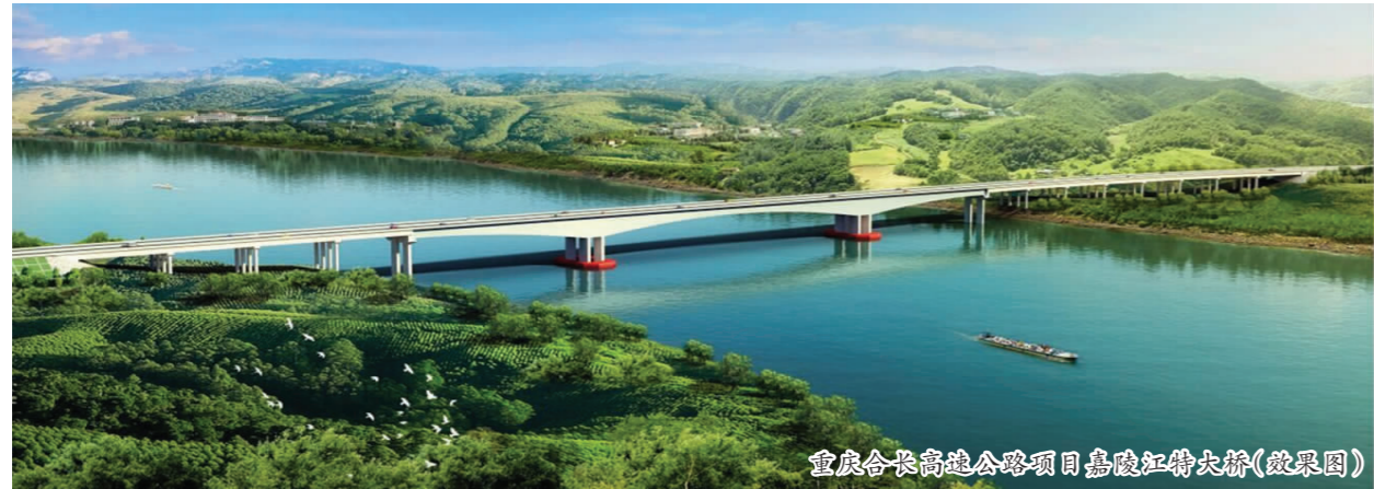
重庆合长高速公路项目嘉陵江特大桥(梁国因)
