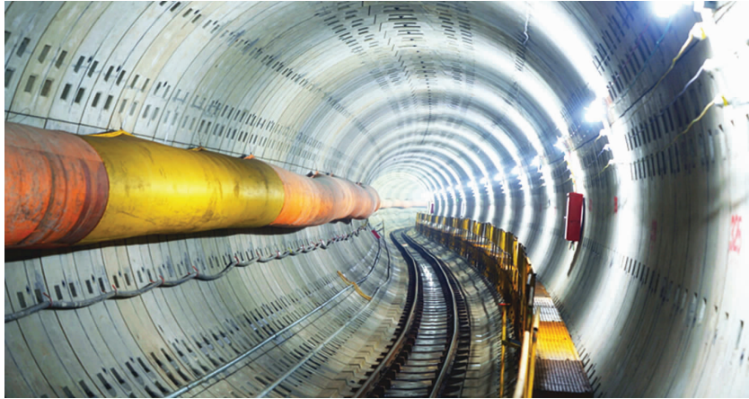
盾构公司承建上海地铁13号线项目三次穿越磁悬浮桩基，完成多项世界首例。图为出场线区间。
