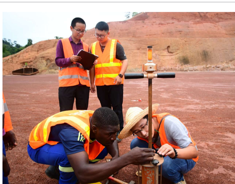
一公局集团喀麦隆项目雅杜高速项目举行第一届岗位技能比武大赛 图为外籍员工正在进行土方压实度检测
