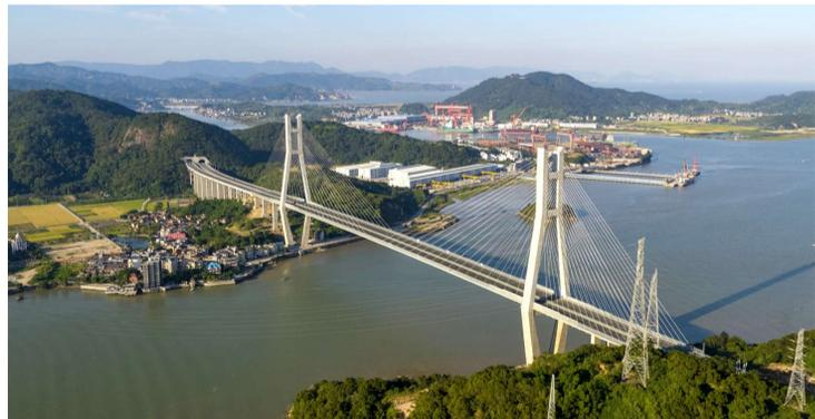
本报讯 9月29日，厦门公司承建的福州长门特大桥正式通车。大桥为双塔双索面混合梁斜拉桥，全长848米，主跨度550米，是福州绕城公路东南段控制性工程，也是闽江入海口的门户桥梁。
