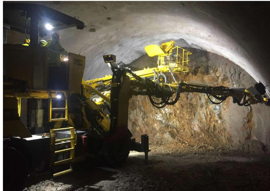
大型隧道施工设备，包括三臂凿岩台车、三臂拱架安装台车、湿喷机械手、自行式液压栈桥、自动挂布台车、新型二衬台车、喷淋养生台车、电缆沟台车、除尘车等。”汤智力如数家珍。
