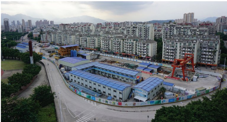
图为6标项目部和南门兜车站现场
