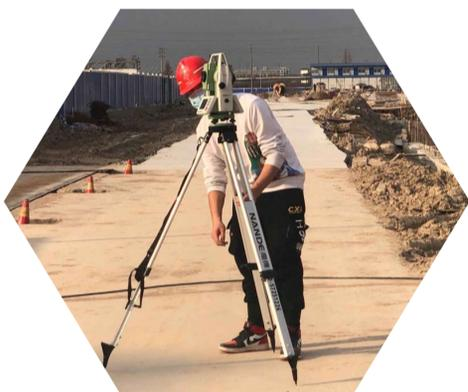
总承包公司位于宁波奉化南浦片安置区块一期及配套工程项目测量技术员正在为全站仪调平。
