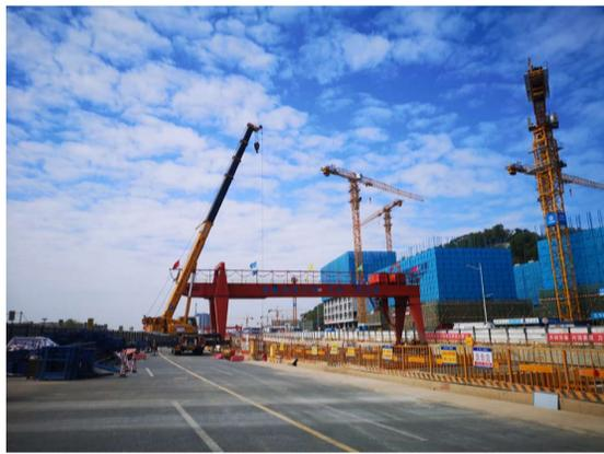
2月24日，四公司深圳公常路项目正式复工生产。在现场，机械声隆隆，钢支撑卸力、主体土方开挖、场地平整、水马拆除等各项工作有序推进。截至目前，该项目已有300多名工人返岗，关键工序施工人员已基本到位。
