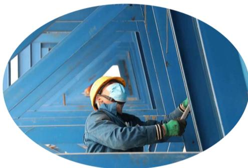
六公司孟州黄河大桥项目50米波形钢腹板梁预制区，工人正在进行终拧高强螺栓，外侧螺帽固定扣紧工作。
