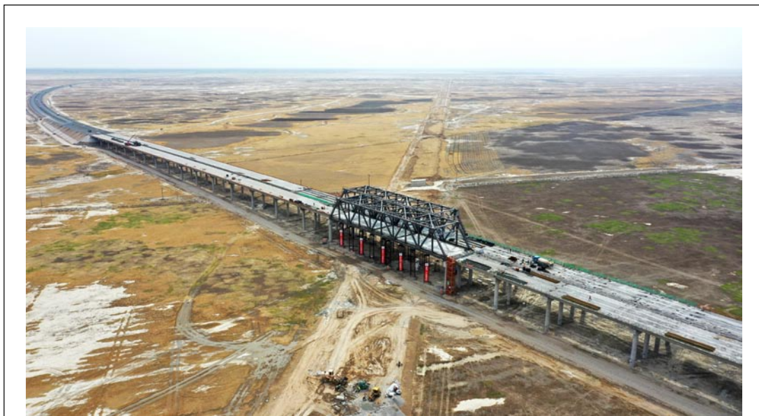
本报讯 近日，松通高速公路项目四工区长西公铁分离桥主桥桥面板浇筑完成。
